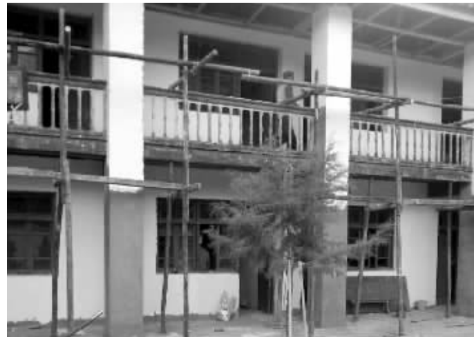
正在施工建设的幼儿园 村民供图
