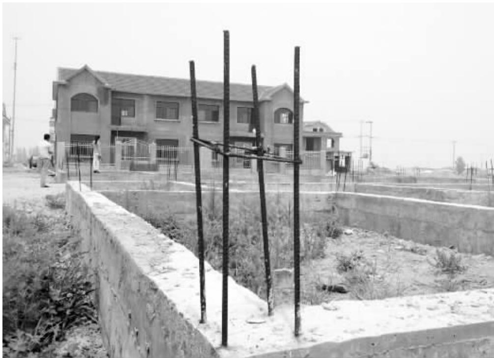
规划中的小区,建好的房子前是刚打下的地基,地基上钢筋已经生锈
