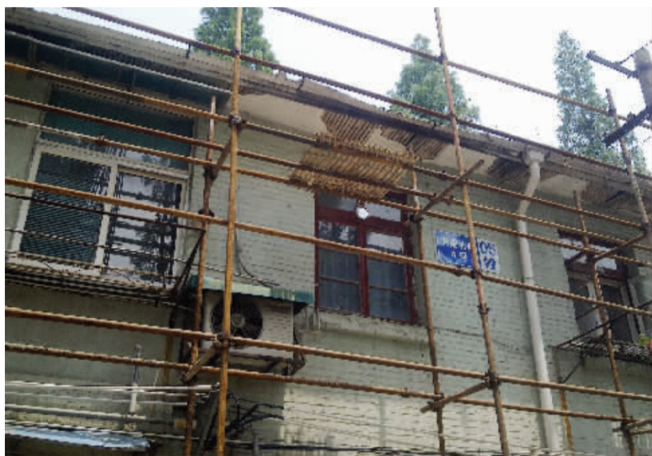
开裂的墙面,残破的屋檐,杂乱的线管,发霉的墙壁……虎踞北路4号大院五号楼的景象可谓“险象环生”
