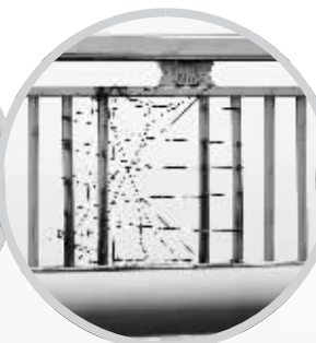
护栏锈迹斑斑, 破损明显
