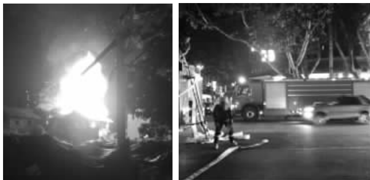
▲消防人员赶到现场 ▲拆迁工地突发火灾
