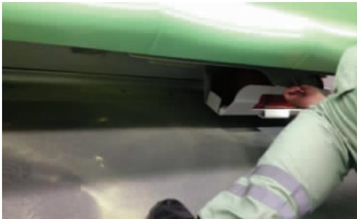
工作人员在检修出现故障的灭火器 图片来自微博
