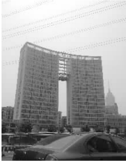
被举报的常州“大裤衩”楼正在安装连接部分的装饰造型
