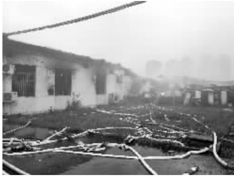
在大火中,部分厂房发生坍塌
