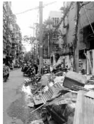
拆违现场 现代快报记者 仲茜 摄
