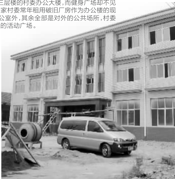
在建的三层楼房就是瞿家村村委以后的办公楼
