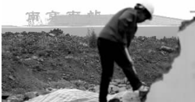
工人正在拆除渣土场围墙 现代快报记者 顾炜 摄
