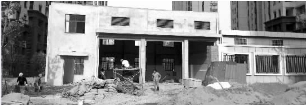
在建垃圾转运站(上图)的斜对面就是幼儿园
