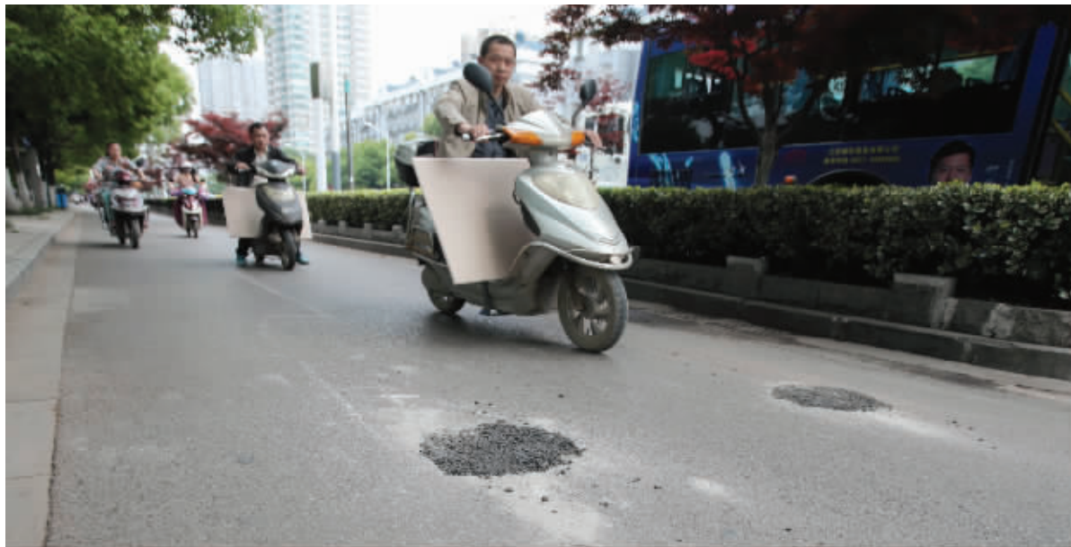
水西门大街北侧慢车道上的隔离桩已经拆除
