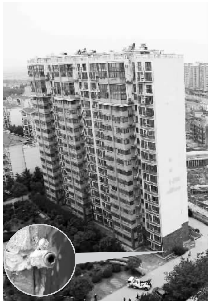
相关部门在楼房上设置了沉降监测点
