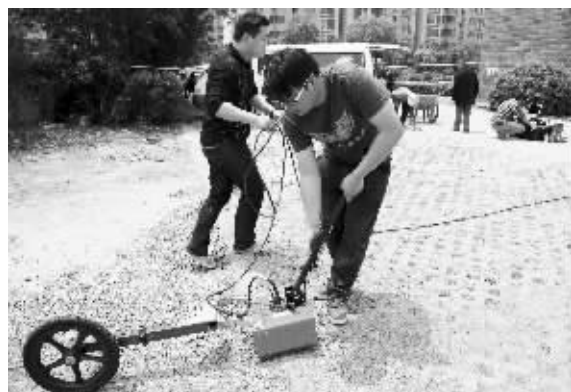
工作人员正在检测地下是否有空洞
