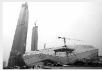
目前正紧张施工, 预计6月底基本竣工
