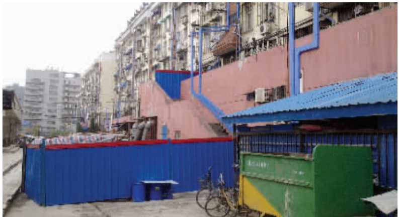
白鹭花园113号楼已被围挡，正在进行修缮
