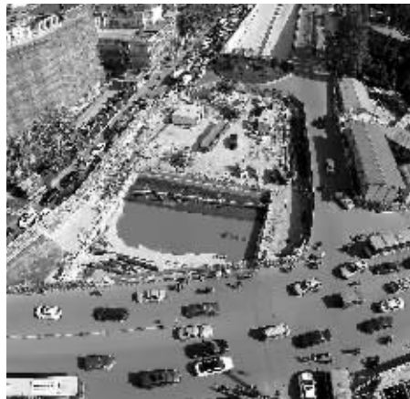
城西干道草场门南北方向道路围挡将改变 现代快报记者 顾炜 摄
