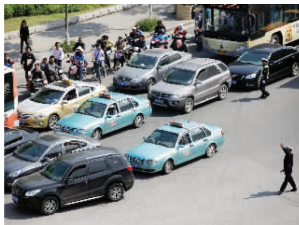
5月4日夜里，南京地铁四号线九华山路工地，工人们连夜抢修(左图)事故发生后，警方实施交通管制(右图) 现代快报记者 廖健伟 邱稚真 摄
