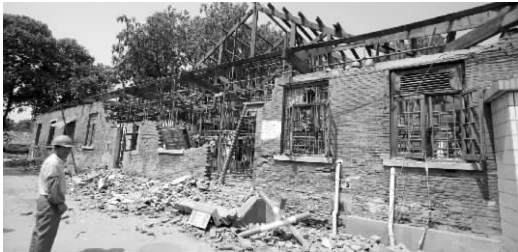
民国海军医院旧址,正在拆卸的墙体 现代快报记者 马晶晶 摄
