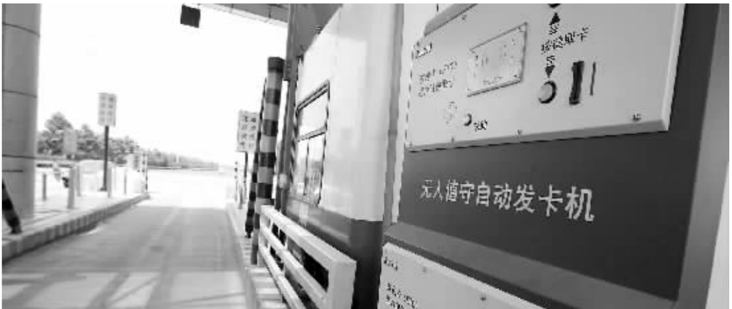
高速公路收费站通道自助发卡通道 现代快报记者 顾炜 摄
