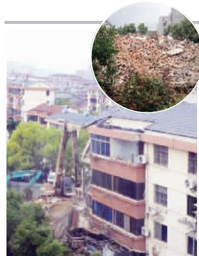
大图：大型机械设备正在拆除危楼
