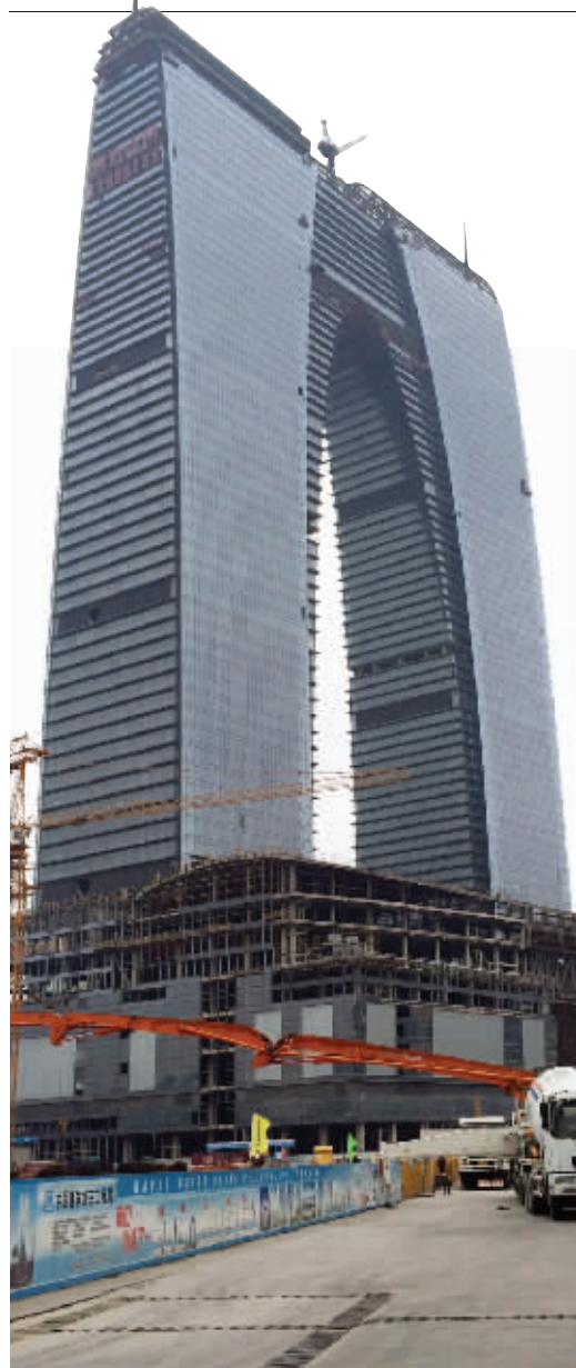
东方之门项目在正常施工 现代快报见习记者 尹焱 摄
