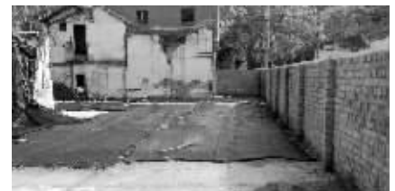
评事街一拆迁工地外围砌起了一道围墙
