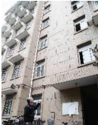
住在核工桂花园的周富云想装一部电梯 现代快报记者 徐洋摄
