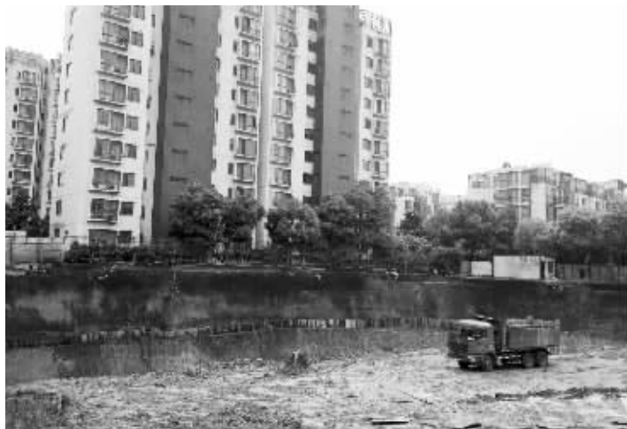
基坑施工离居民楼很近 刘国庆 摄
