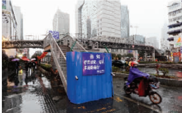
天桥封闭后,给过马路的行人带来了不便 现代快报记者 赵杰 摄
