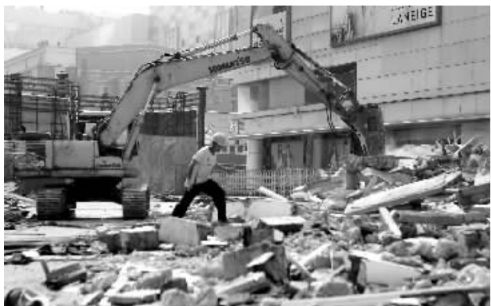
昨天上午,这幢小楼被拆掉了
