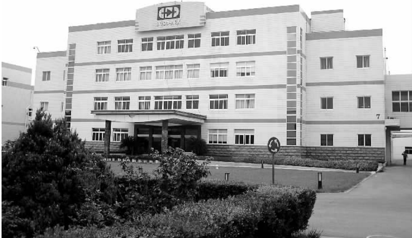
苏州固锴公司大楼 资料图片
