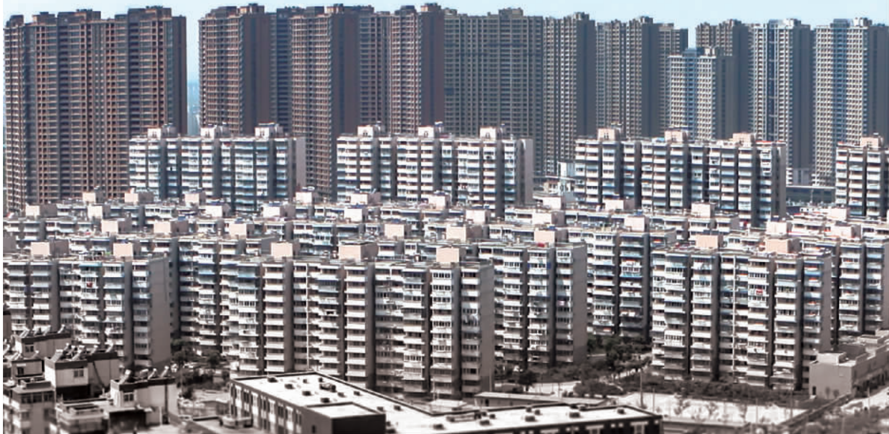
南京最大的安置房片区岱山新城因缺乏配套设施、配套管理让先期入住的人们感到很不方便 实习生 丛容 摄
