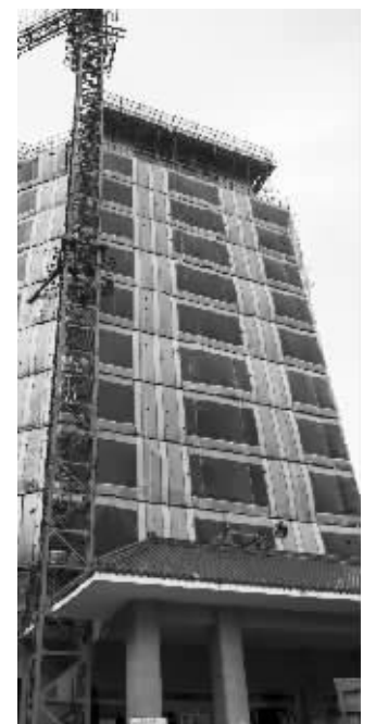
围挡看起来像玻璃幕墙 实习生 丛容摄
