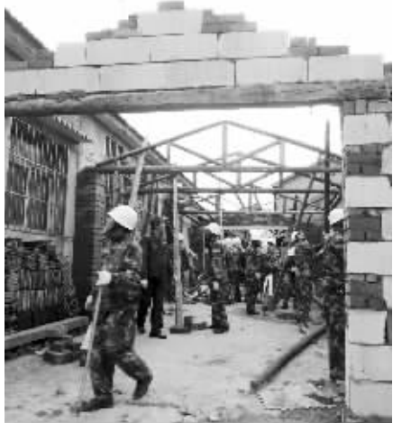
街道组织人员来拆违建 西善桥街道供图
