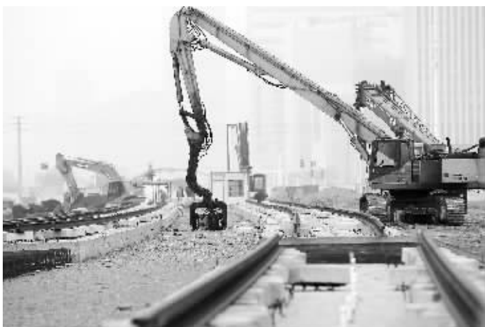
河西有轨电车项目正在进行铺轨施工 现代快报记者 顾炜 摄
