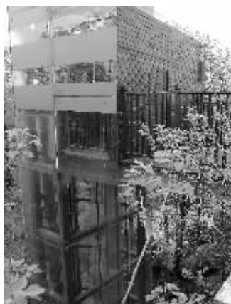
上下城墙的电梯
