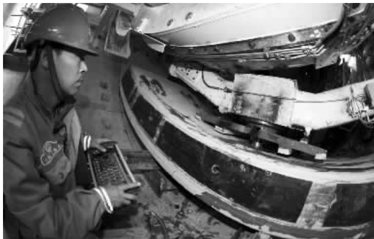
施工人员在调试盾构机
