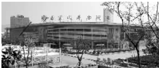
火车站北广场边上的小红山长途客运站已基本完工
