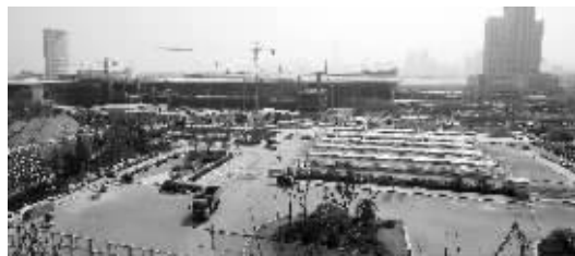
在建中的南京火车站北广场
