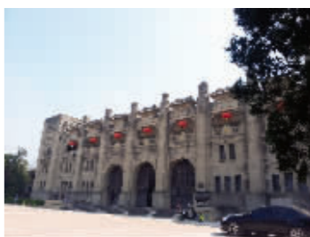
中央体育场牌楼建筑
