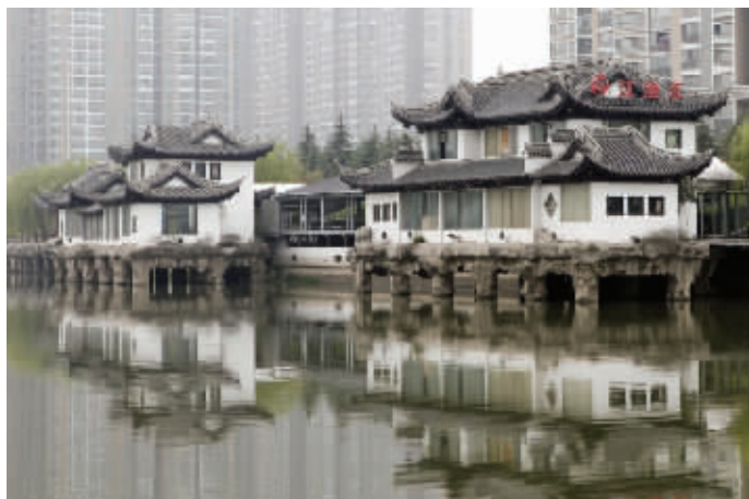
被叫停的“江鲜馆”位于秦淮河河堤上, 环境十分优美, 建好后一直闲置 现代快报记者 邱稚真 摄
