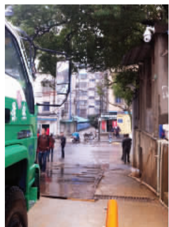
水佑岗三乐工地新装的监控探头 现代快报记者 赵丹丹 摄
