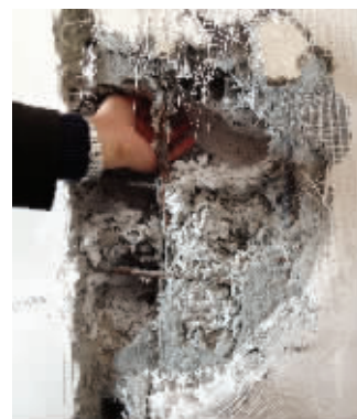
承重墙内藏有的泡沫
