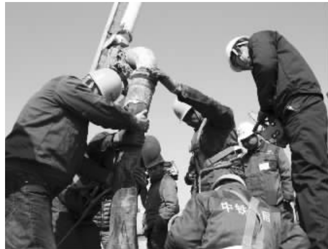
连盐铁路第一墩开始浇筑 姜振军 摄
