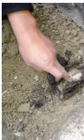
地砖一敲开，就看到下面铺的全部是松软的黄沙
