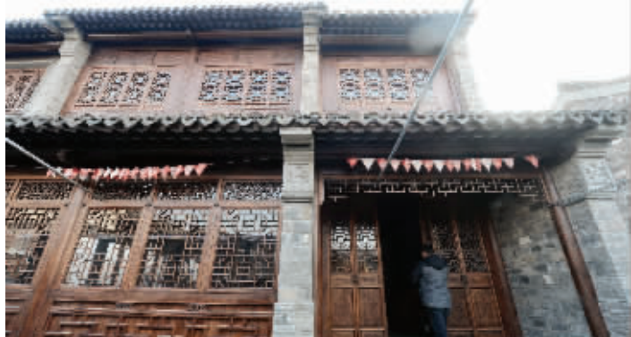
问柳茶馆位于箍桶巷121号,建筑面积1600平方米 现代快报记者 赵杰 摄
