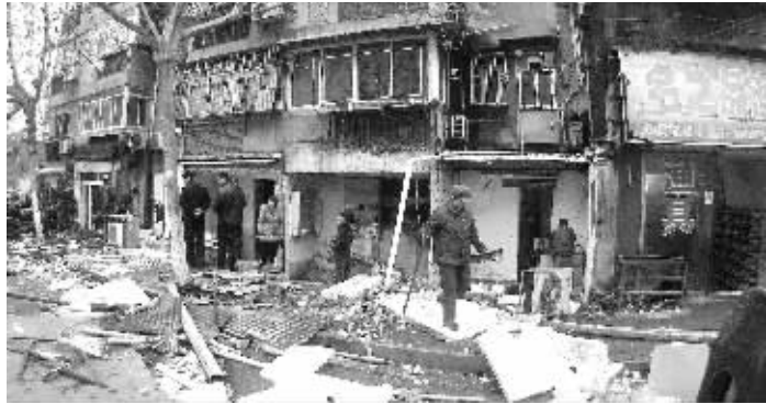
凤凰西街拆违 通讯员供图
