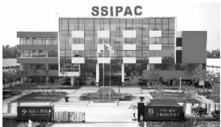
位于宿迁的江苏苏州宿迁工业园区,是宿迁苏州两市紧密合作共建的新型工业园区,连续多年在全省南北共建工业园区考核中名列第一
