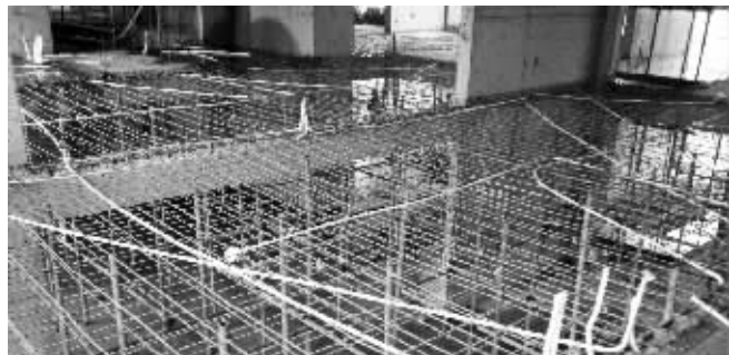
楼面敲掉后重新浇筑 刘国庆摄
