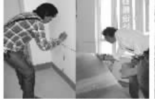
第三方监理单位进行工地验收
