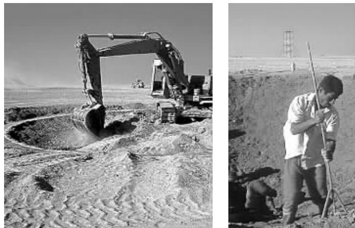
“沙漠呼吸”的建造移走了约8000立方米沙子, 移走的那些沙子, 变成了锥状体
