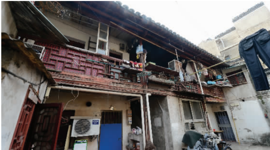
老门西高岗里17号到19号内建筑
