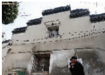
高岗里17号到19号内建筑
