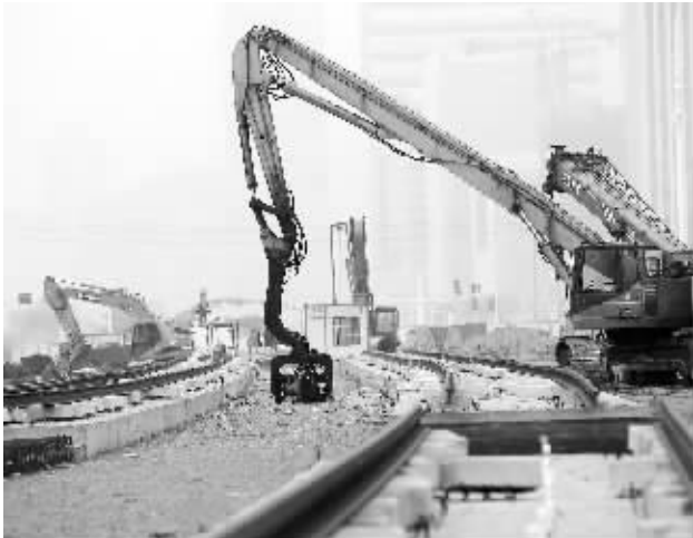
电车轨道正在铺设中 现代快报记者 顾炜 摄
