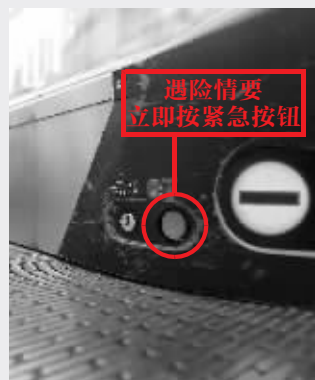
商场内的自动扶梯上,紧急停止按钮是红色位于扶梯下方 现代快报记者 马晶晶 摄
